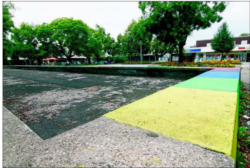
Statt des Wasserbeckens soll es auf dem Platz abschaltbare Wasserfontänen geben, am Hang werden Sitzstufen gebaut. Foto: Isabelle Butschek
