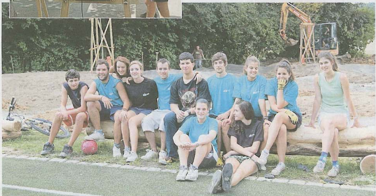
Insgesamt 15 Jugendliche aus Deutschland, Spanien und der Slowakei waren beim Bau des Fahrradparcours beim Jugendhaus Weilimdorf im Einsatz
